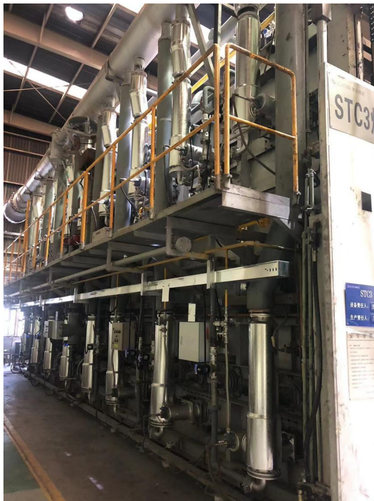
图 7.2-4 完成改造的 STC 炉
