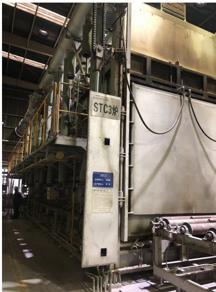
图 7.2-3 拆除换热器及烧嘴后 STC 炉
