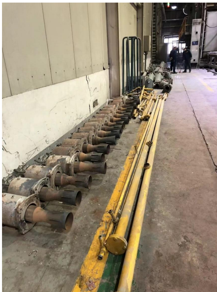
图 7.2-2 拆除现场照片
